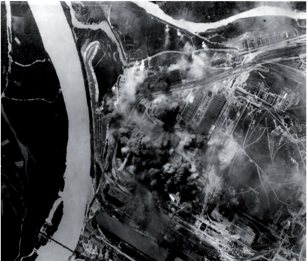
Die „Herrmann Göring Stahlwerke“ in Linz wurden durch einen Bombenhagel eingedeckt. (HF)
