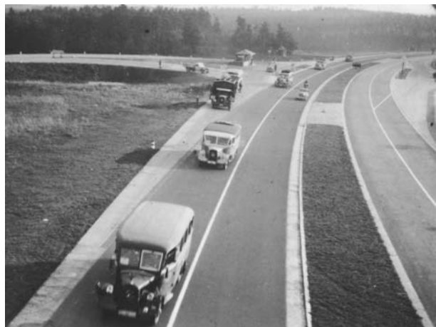
Omnibusse auf der Autobahn. Beachte die kurzen Beschleunigungsspuren und die noch fehlenden Pannestreifen (KE)
