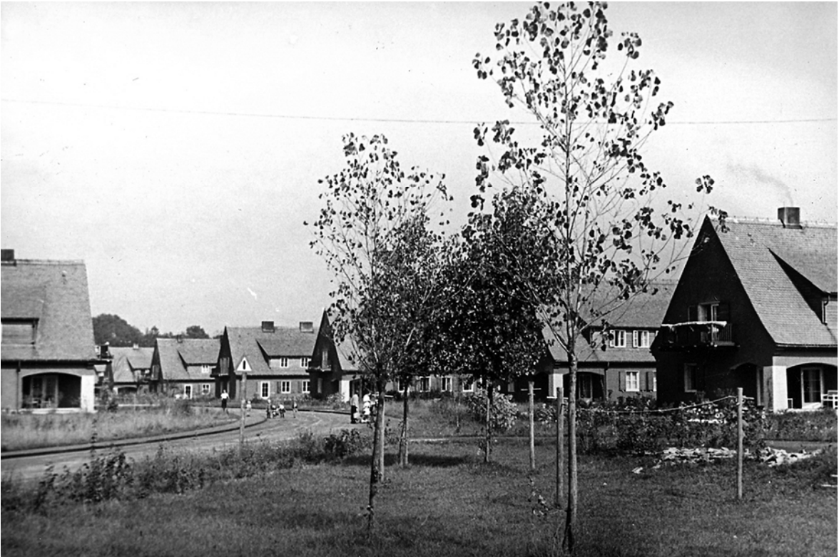
Die Wohnhäuser der Werksiedlung Herzograd nach der Siedlungseinfahrt: Von rechts vorne nach links hinten: drei Wohnhäuser nach Typ 4 (Herzograd 4, 6 und 8). Dann das Dreifamilienwohnhaus (Herzograd 10) und das Zweifamilienwohnhaus (Herzograd 12). Ganz links ebenfalls ein Wohnhaus nach Typ 4 (Herzograd 11). [Archiv ECS]
