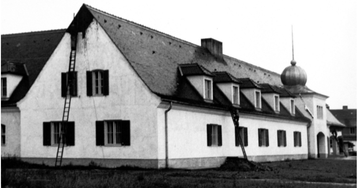
Das Angestelltenheim in der Werksiedlung Herzograd erhielt im Frühjahr/Sommer 1943 einen dunklen Anstrich. [Doku STV]
