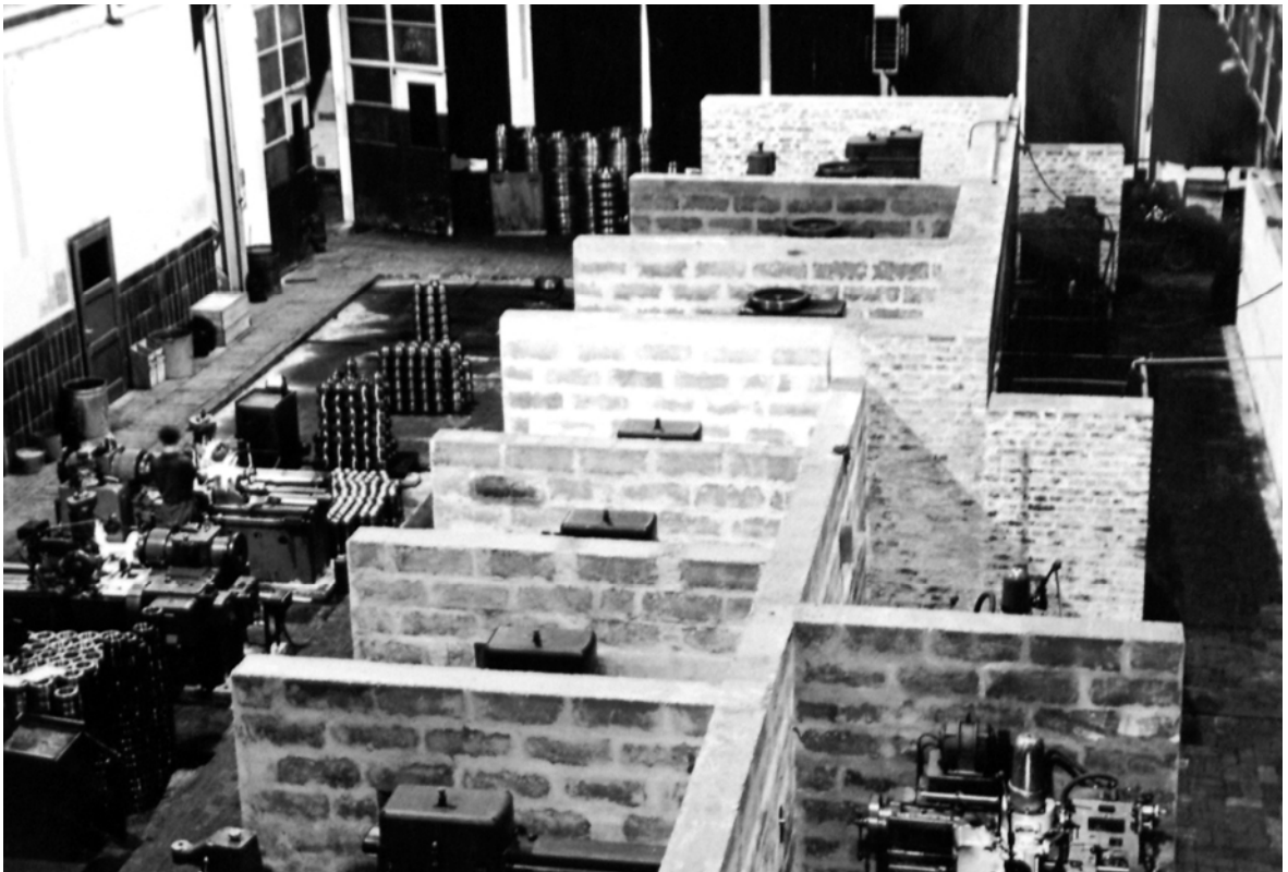
Aus Klinkerziegeln gemauerte Splitterschutzwände sollten in der Halle I die hochempfindlichen Zahnradfräsmaschinen gegen Druckwellen- und Splittereinwirkung schützen. [Doku STV]
