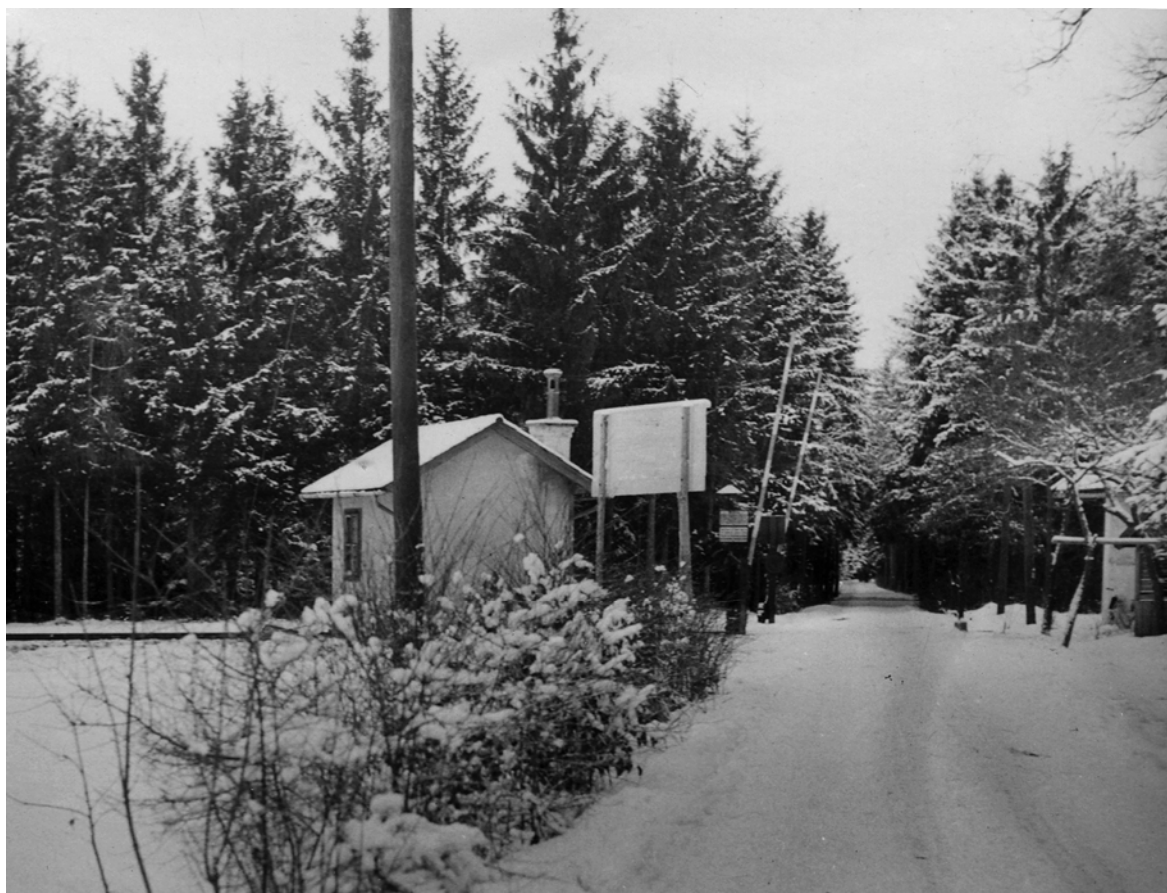
Diese Forststraße war bis zum Bau des Nibelungenwerks die Straßenverbindung vom St. Valentiner Ortsteil Langenhart nach Ernsthofen. Das Schild neben dem Schrankenwärtergebäude am Bahnübergang warnte vor dem unerlaubten Betreten der Baustelle. [BFSTV]
