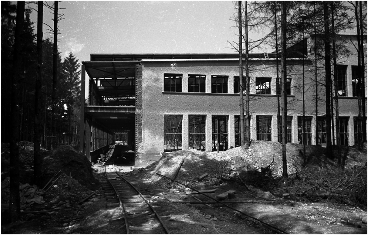
Die Bauarbeiten an der Halle I im Sommer 1941. Die Halle I unterschied sich von allen anderen Hallen durch ihre besondere Architektur. [Archiv ECS]
