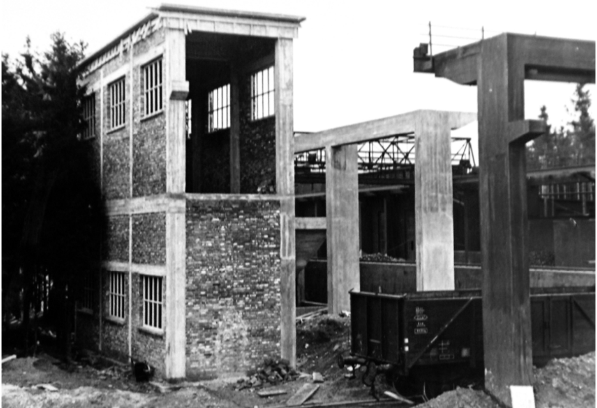
Der fertig gestellte und in Betrieb genommene Kohlenlagerplatz für das Kesselhaus im Sommer 1941. [Doku STV]
